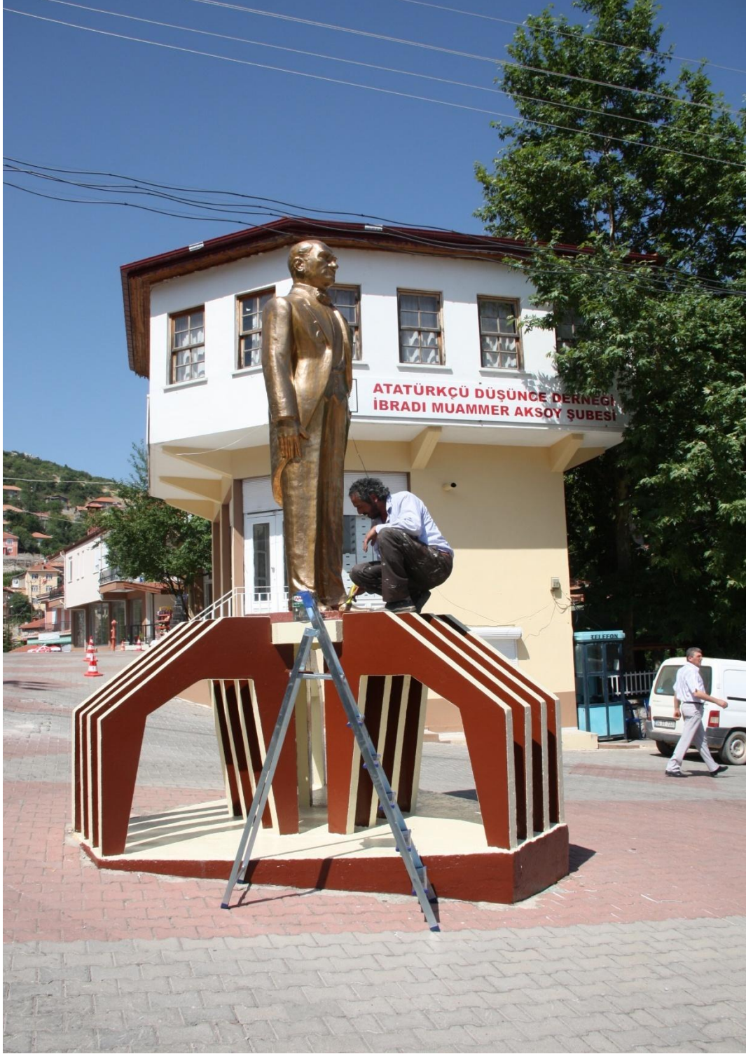
İlçemiz Merkezindeki Tarihi Atatürk Anıtının Bakım ve Onarımı Yapıldı.
