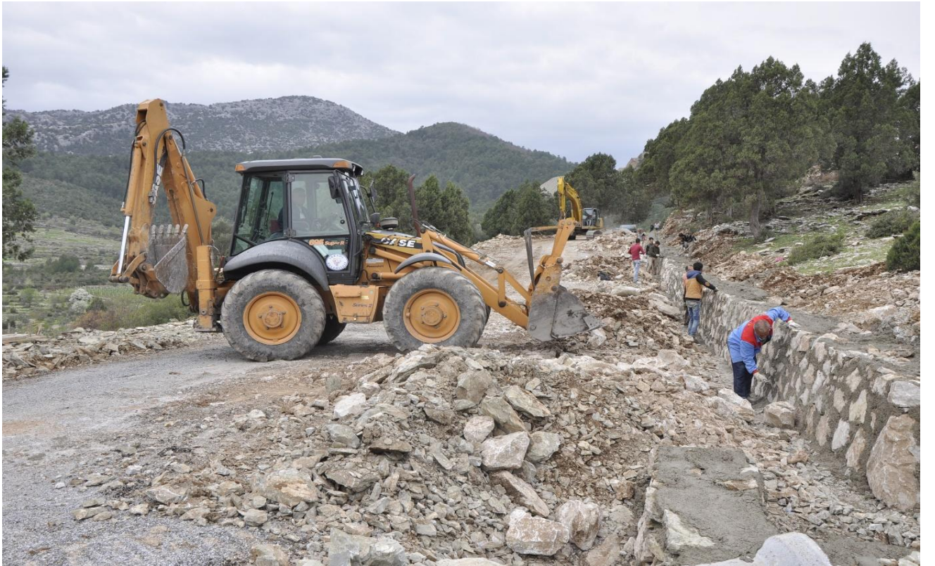
Düzlen mahallesi yol kavşağı düzenleme çalışmalarımız.
