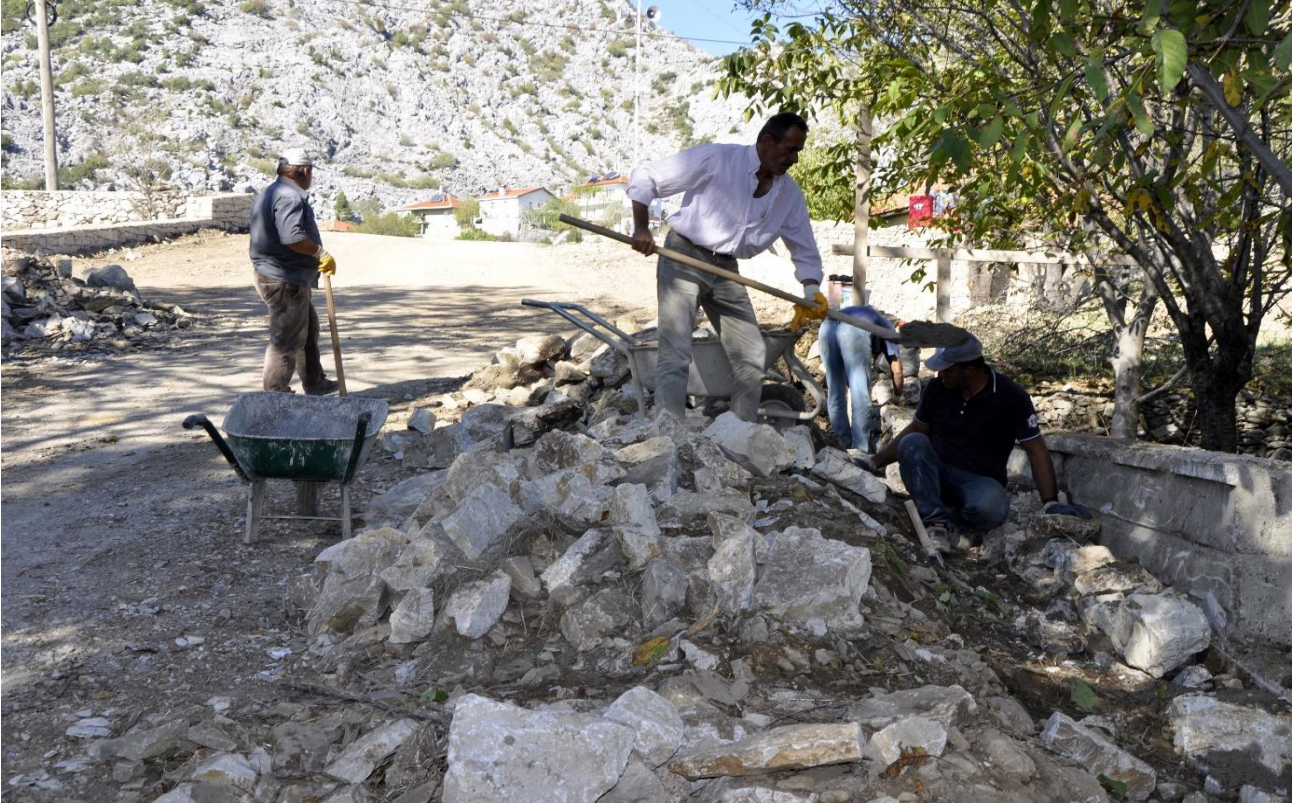
Yol yapım çalışmalarımız devam ediyor.
