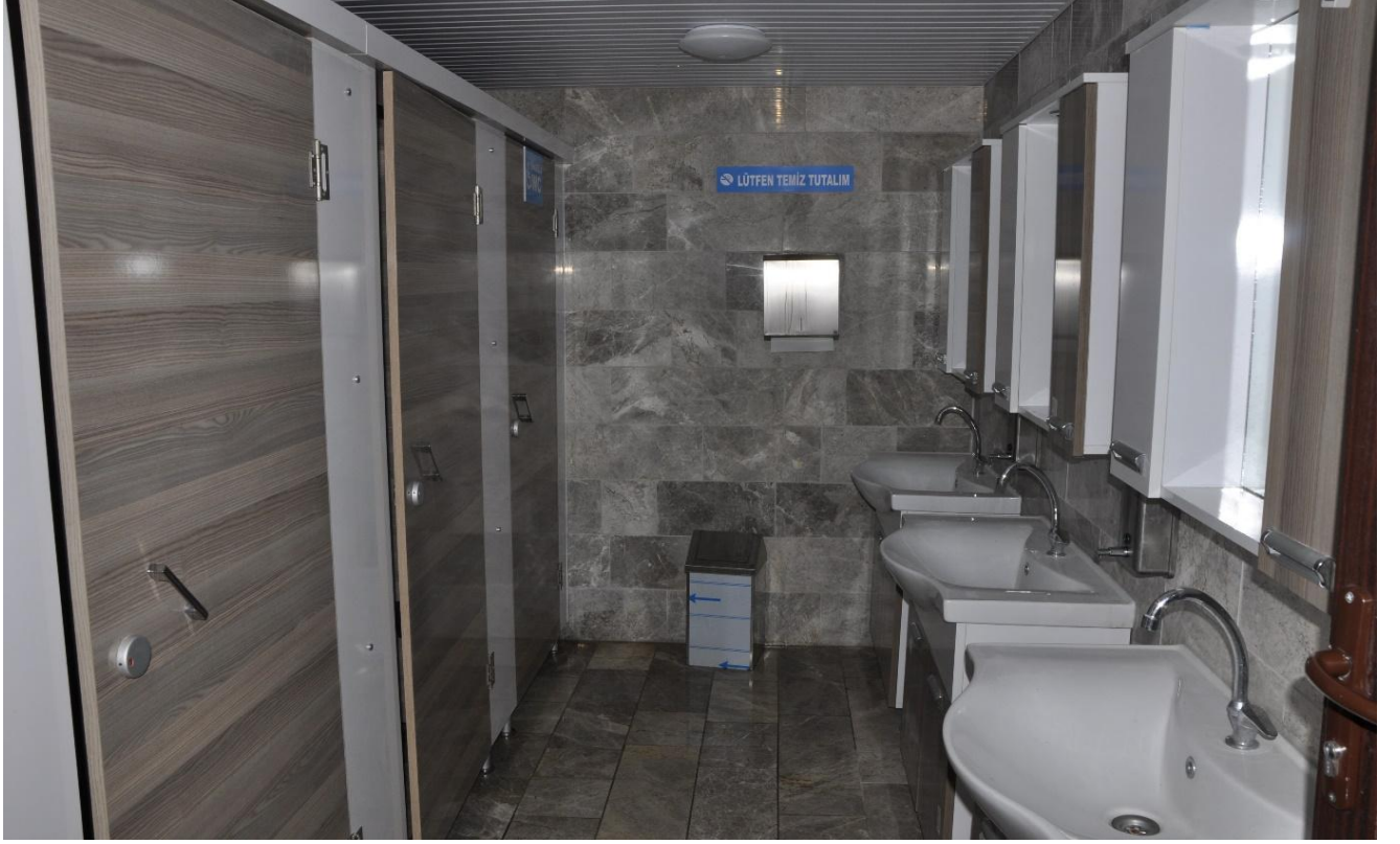
Tuvalet İnşaatını tamamlayarak hizmete açtık.
