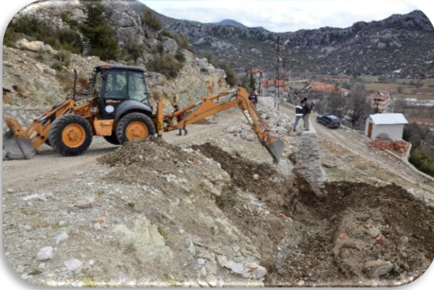
İlçe merkezinde Şehit Bilal Bostanoğlu Sokağı ve Saytaş Caddesi üzerinde bulunan yokuşun istinat duvarlarını yapılarak, yola bakan cephe bahçelerinin yıkılmış duvarları yenilendi.
