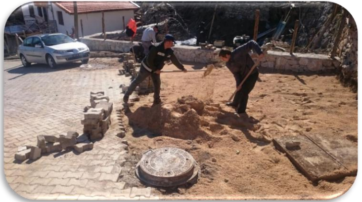
Aşağı Mahallede kilitli parke taşı döşenmiştir.
