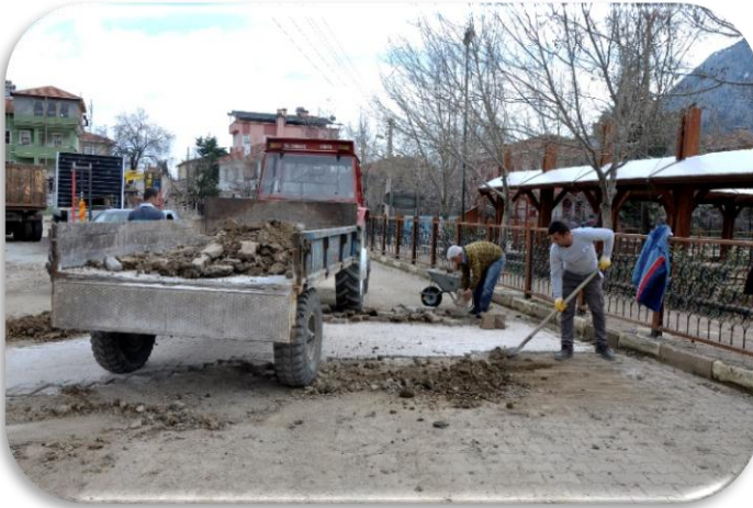
Ormana Mahallesi, Harman Mevkii yol bakım çalışması yapılmıştır.
