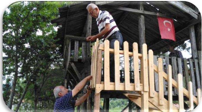
Maşat Mahallesinde simgesi olan çardağın bakım ve onarım çalışmaları yapıldı.
