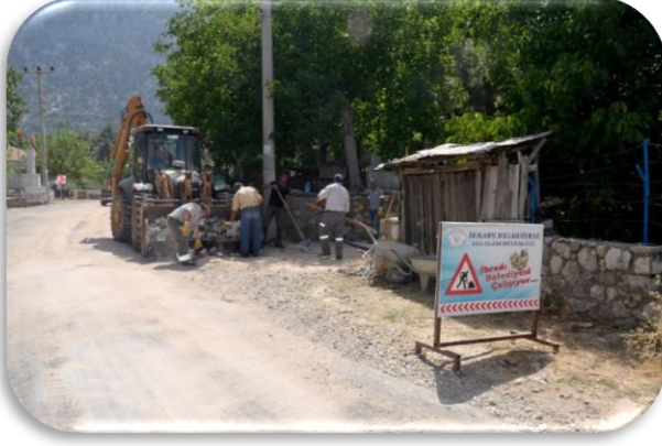
Ormana Mahallesi Mezarlık arası yolda kilitli parke taşı döşenmiştir.
