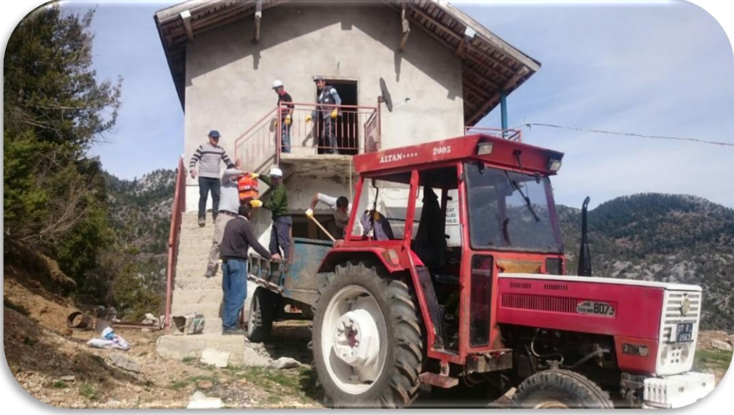
GSM hatlarının çalışmadığı Maşat Mahallesinde verici takılmadan önce altyapı çalışmaları tamamlandı.
